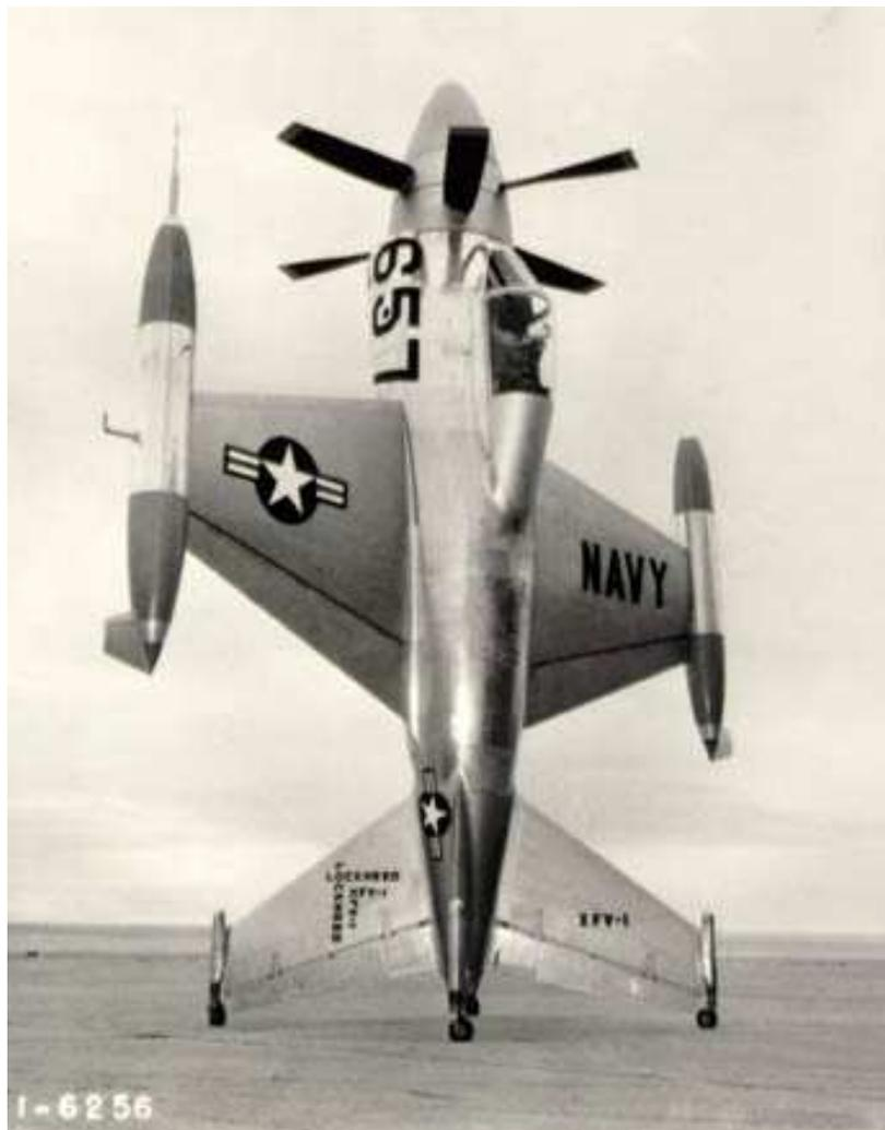
Typ: Prototyp eines VTOL-Kampf-
