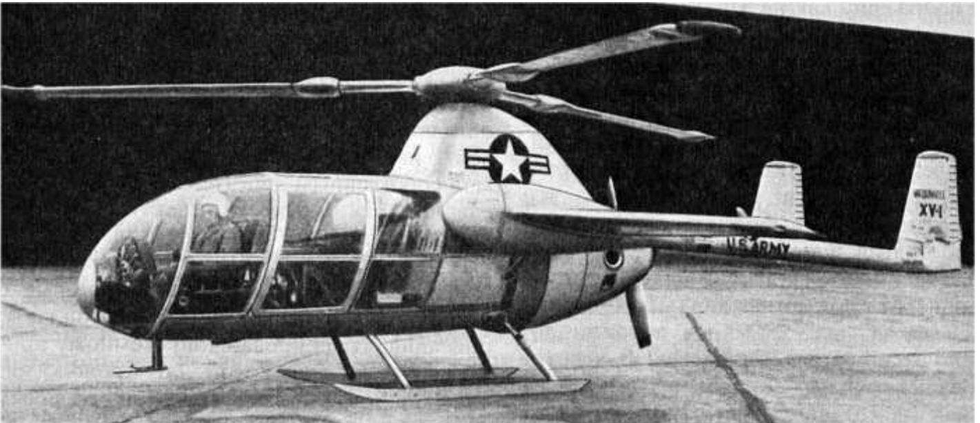
Der XV-1 flog am 11. Februar 1954 mit dem Testpiloten John R. Noll. Das Halteseil war mit Bleigewichte versehen, die dazu bestimmt waren, das Flugzeug in Bodennähe zu halten, bis Probleme mit dem Tip-Jet-Antriebssystem des Rotors gelöst waren. Am 14. Juli 1954 wurden die Bleigewichte entfernt und der XV-1 führte seinen ersten freien Schwebeflug durch. Als die Flugerprobung fortgesetzt wurde, fertigte McDonnell die zweite Maschine (Serial 53-4017).
